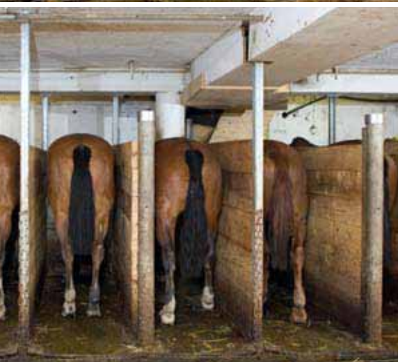
les anciennes stalles (photos du haut) en stalles d'alimenta- la hauteur des parois de séparation pour pouvoir faire ressortir stalles voisines.
