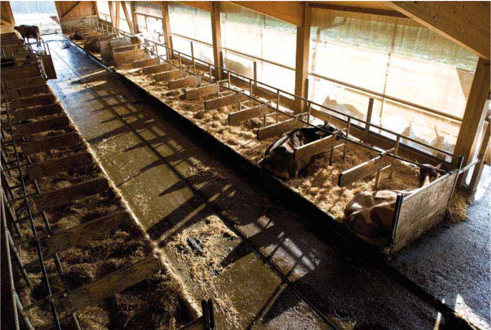
Une stabulation clairement divisée en aires d'alimentation, de repos et de mouvement est une des principales conditions architecturales pour que les troupeaux cornus vivant en stabulation libre soient tranquilles et équilibrés. Et le dimensionnement généreux de l'aire d'attente peut être décisif. Ci-dessus, la stabulation libre du Herterenhof à Wettingen AG (cf. page 7).
