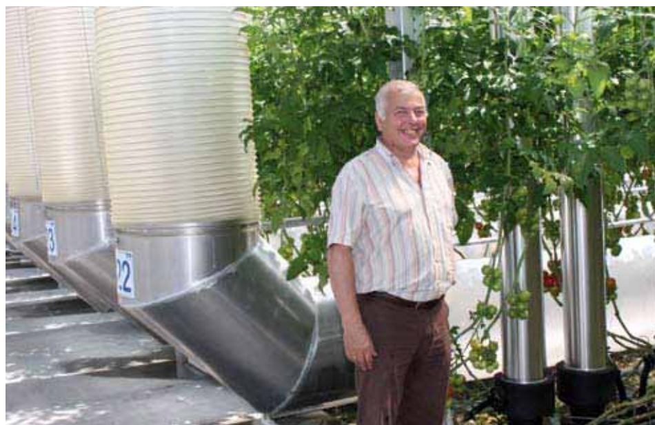
Aad Jonker, le père du chef d'exploitation Arno Jonker, devant ses tomates. Les tuyaux en plastique qu'on voit derrière lui transportent de l'air frais en été et de l'air chaud en hiver.
