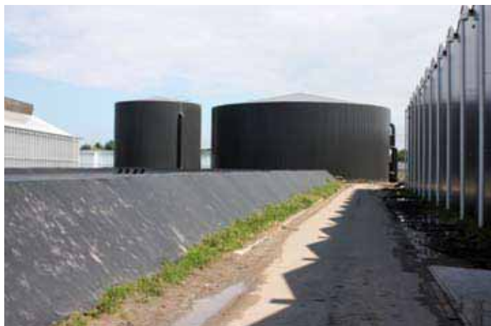
Une formidable prouesse technologique pour supprimer les saisons: À gauche la salle des machines où circulent la chaleur en hiver et le froid en été, et à droite le grand réservoir pour l'eau de pluie ainsi que le réservoir-tampon pour l'eau respectivement froide ou chaude pompée dans le sous-sol.
