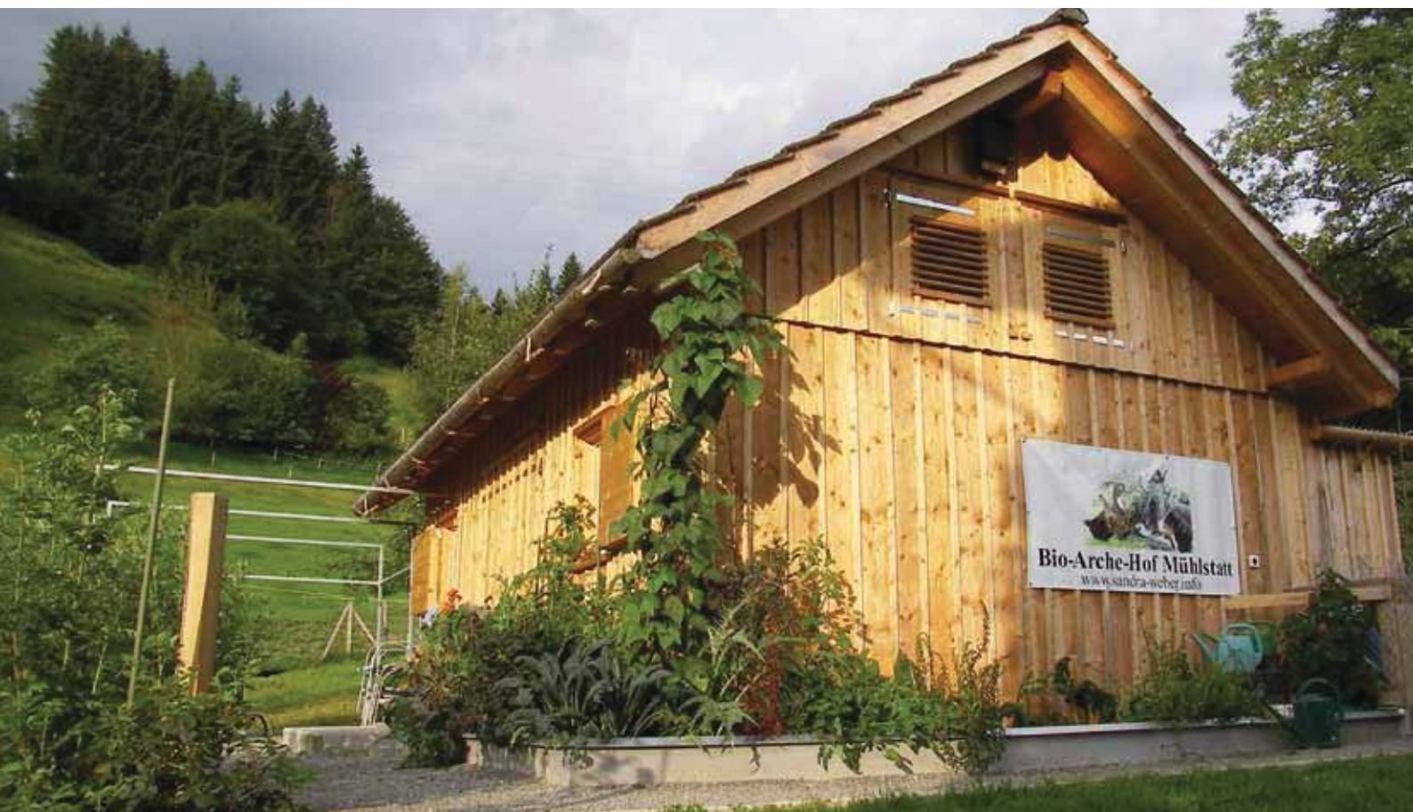
La nouvelle Maison des Visiteurs de la Ferme de l'Arche bio de la famille Weber-Neff a pu être construite grâce au projet de développement régional.
