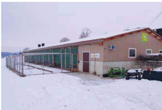
Le poulailler des 2000 pondeuses bio des Bigler est installé dans une nouvelle halle de 40 mètres sur 12.
