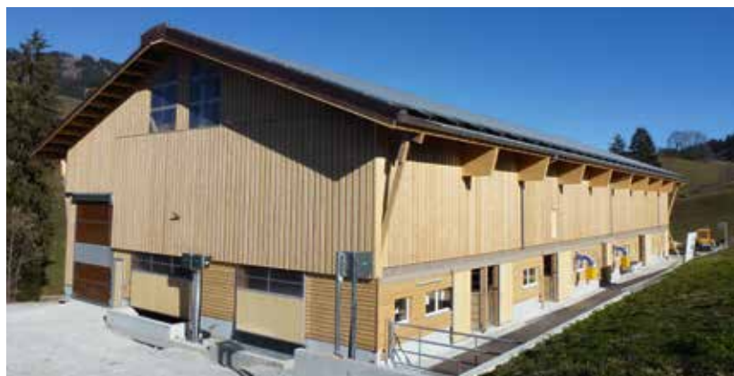
La chaleur dégagée par les cellules photovoltaïques peut être utilisée par exemple pour le séchage en grange.
