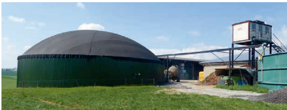
L'installation du domaine Zosso produit chaque année quelque 700 000 kWh d'électricité. Photo: Andreas Messerli
