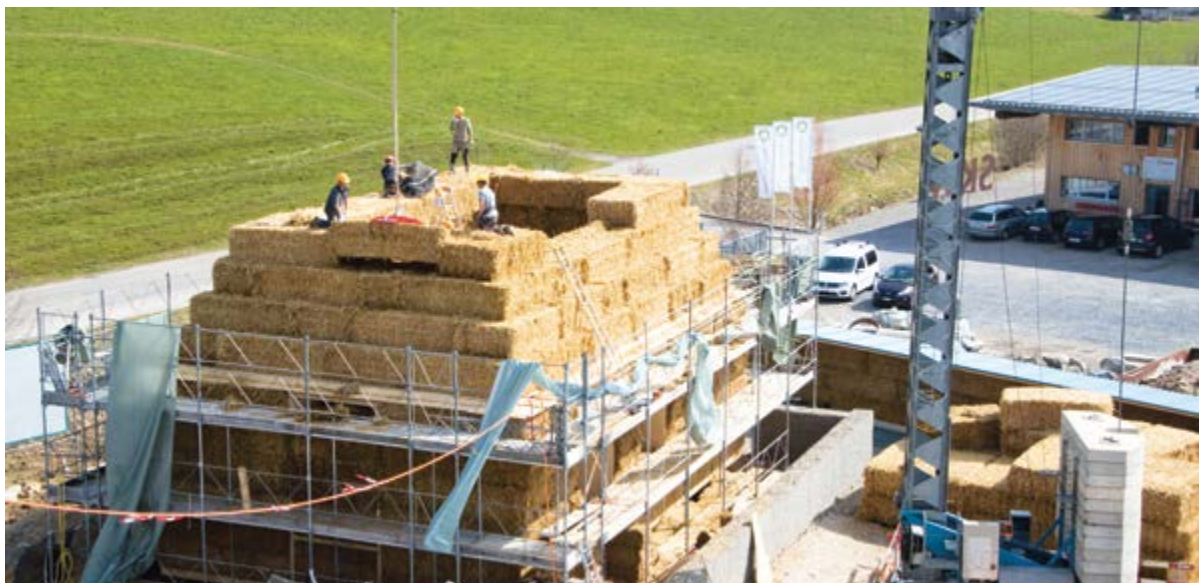
Werner Schmidt a développé pour la société de paysagisme Gartist de Bubikon ZH une maison en balles de paille avec encorbellement.
