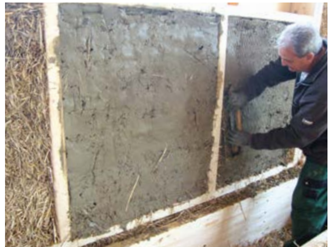
L'isolation en paille d'épeautre a été enduite d'argile. Photo: mäd
