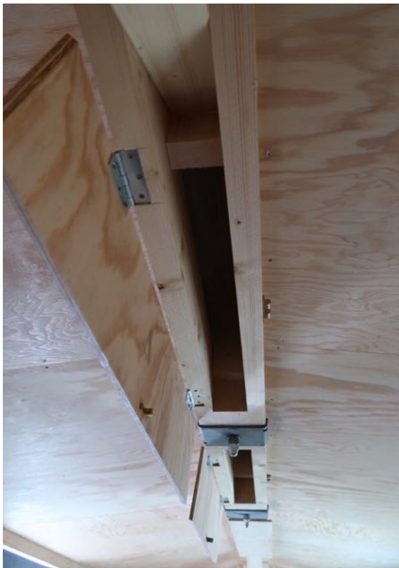
Abbildung 3: Lüftungsöffnungen im First mit Verschlussklappen (Bild: Tanja Kutzer)
